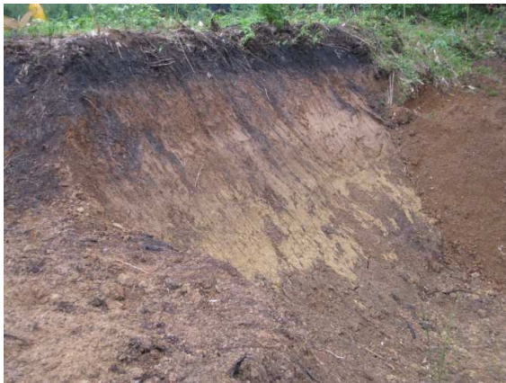
南部町池野 ⇒腐食土 (黒色) ⇒
