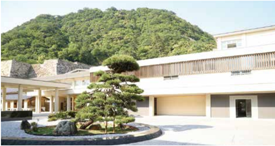
耐震改修工事が完了した西高校舎
